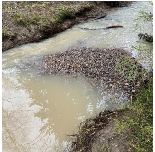
Kunnostustöitä Palonummenpurolla Siuntiossa. Siuntion joet ja purot ovat luonnostaan savisameita. Kevättulvien aikaan vesi on erityisen ruskeaa.
